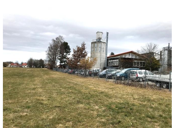
Abbildung 10: Blick nach Nordosten auf den Bestandsbetrieb der „Boneberger Schreinerei GmbH“ mit Stellplätzen
